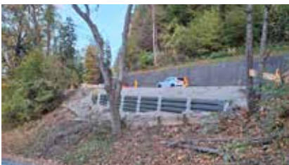
Hangsicherungsarbeiten an der Landesstraße zwischen Volderwaldhof und Glockenhof, 21. Oktober
