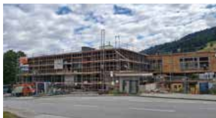
Bau Haus der Generationen, 27. Juni
