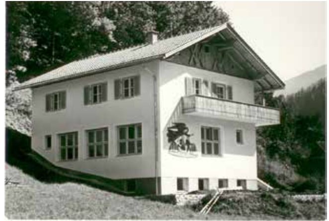
Schulhaus Volderwald, August 1957 (Foto Franz Thaler)
