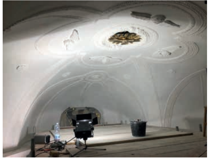
Die Restauratoren haben in stundenlanger Feinarbeit die Strukturen herausgearbeitet
