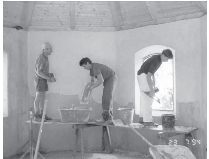
Verputzen des Innenraumes am 23. Juli 1994, von links: Hermann Parger, Martin Arnold, Gerhard Junker
