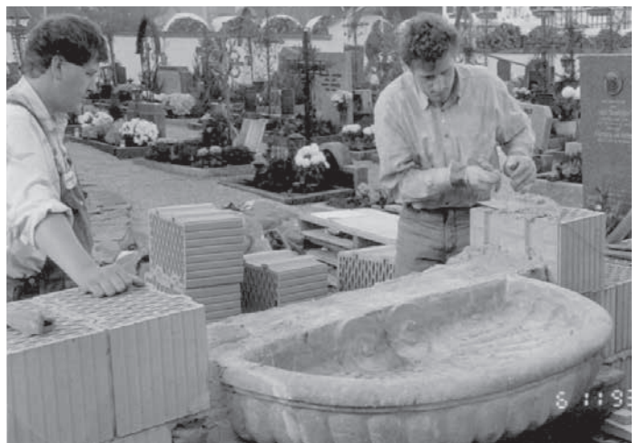
Das alte Weihwasserbecken wird wieder eingemauert – 6. November 1993. Christoph Gatt (links) und Manfred Arnold
