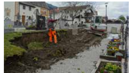
Grabung für die Urnenmauer am 15. April
