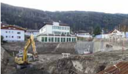
Bodenaushub Haus der Generationen, 19. Oktober
