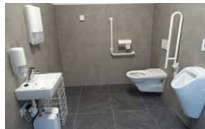
Öffentliches WC im ehemaligen Feuerwehrhaus, 31. Juli
