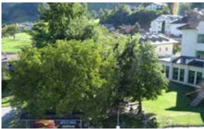
Bauplatz für das Haus der Generationen, 7. September
